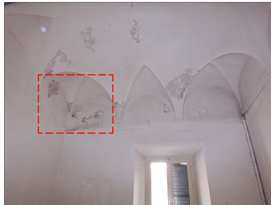
fig.4) volte in incannucciato e gesso al p.p.
