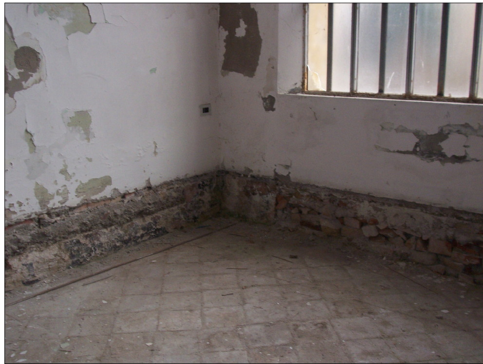
fig.1) pavimento originario in cotto al p.t.
